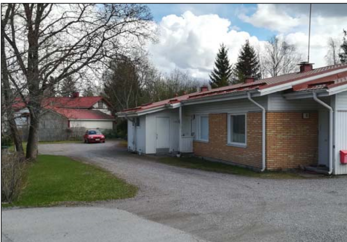
Sillankorvantiehen rajoittuvalle tontille rakennettiin rivitaloja 1980-luvun lopulla.
