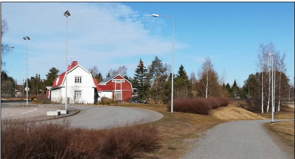
Alikulku rajaa pihapiiriä pohjoisen puolelta. Maaston pengerrys korostaa rakennusten sijaintia maisemassa.
